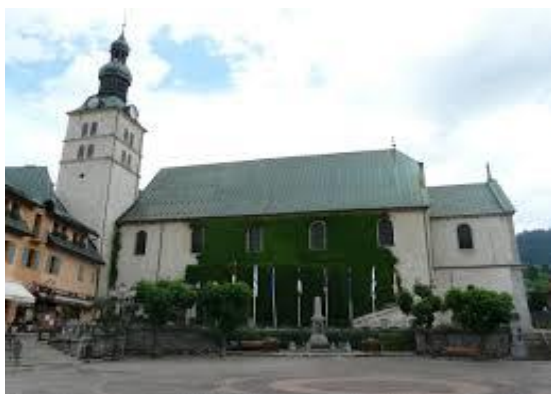
Photo Fondation-Patrimoine (avant)
